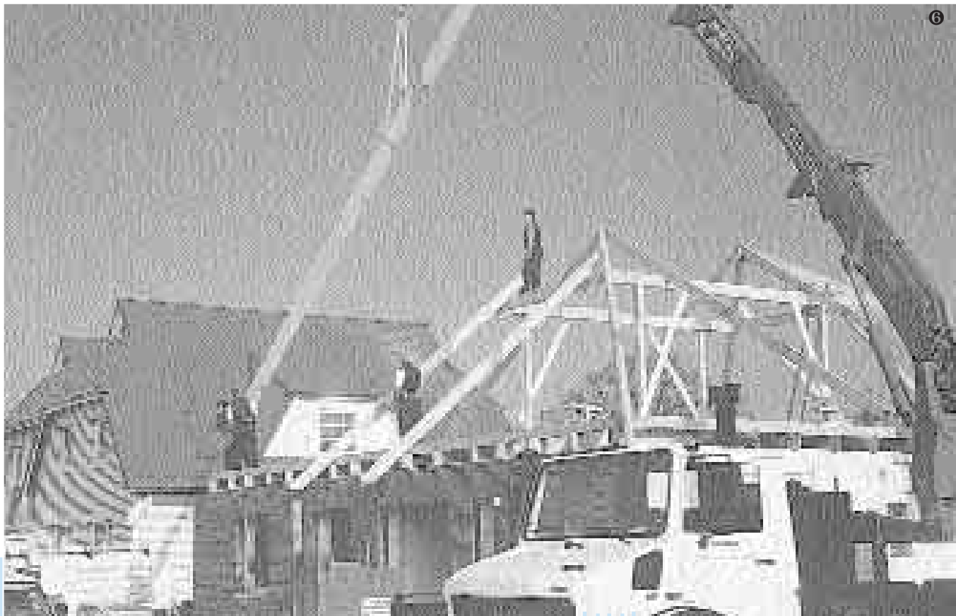
© Der Unimog mit seinen 14,5 t Gesamtgewicht hat kein Problem, den vollbeladenen Anhänger mit 21 t, auf dem das vorgesägte Baumaterial, die vorgefertigten Dachbalken und eine Dachgaube liegen, an die Baustelle zu transportieren. © Zimmermanns-Alltag bei Kühling. Mit dem Kran werden die bis zu 10 Meter langen Gradsparren aus Tannen- oder Fichtenholz auf den Bau gehoben und umgehend festgemacht
